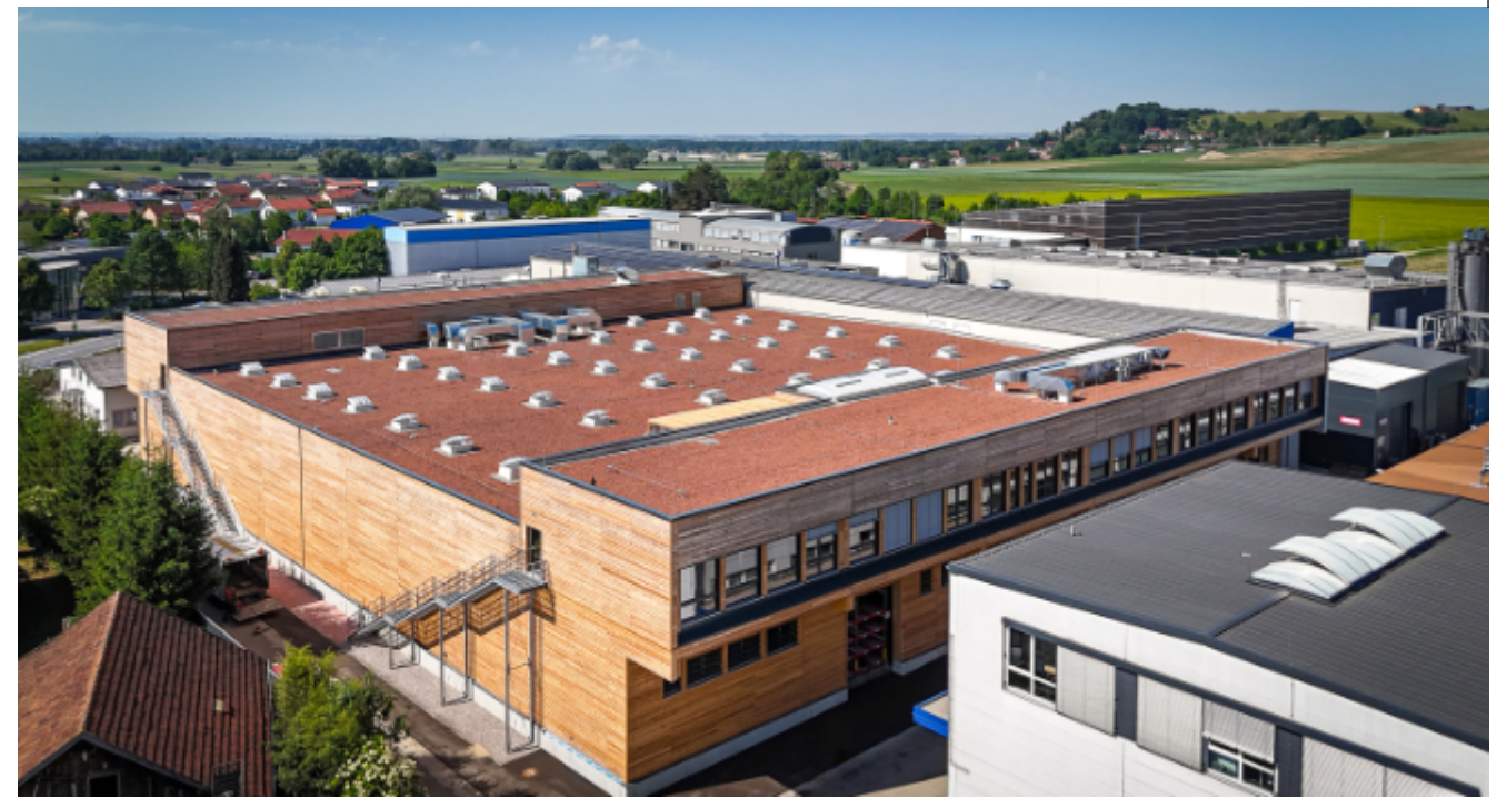
Luftaufnahme der neuen Spritzgusshalle von Wallstabe & Schneider in Niederwinkling, für die das Familienunternehmen rund 12,8 Millionen Euro investiert hat.
