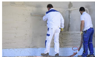
Per Putzmaschine kann die ressourcenschonende „ecosphere“-Dämmung ganz einfach auf die Wand gespritzt werden. Diese Entwicklung aus der Maxit-Ideenschmiede findet nun auch außerhalb der Baubranche besondere Aufmerksamkeit. Foto: maxit
